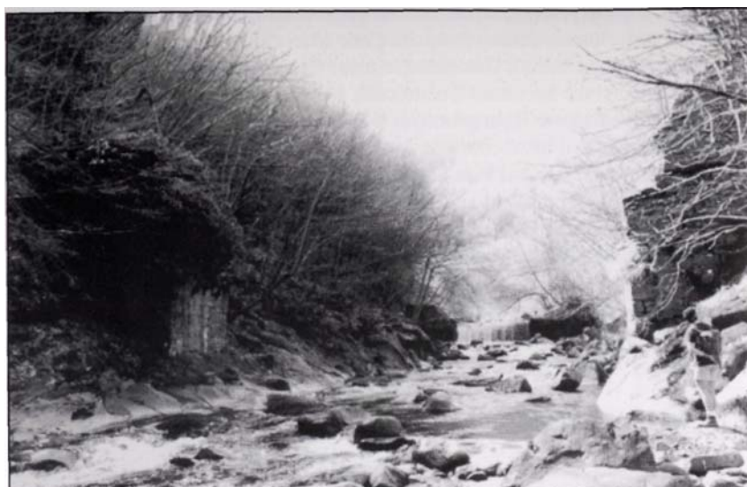
Le rovine del Ponte di Rifolengo
